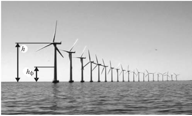
Рис. 4. Высота флюгера ( h_\phi ) и уровня ступицы ветроколеса ( h ) ВЭУ
