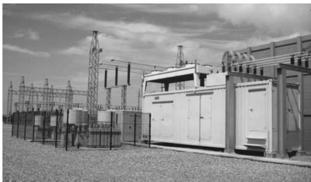
Рис. 6. Статический тиристорный компенсатор 220 кВ («Ансальдо-ВЭИ») в промышленной эксплуатации
