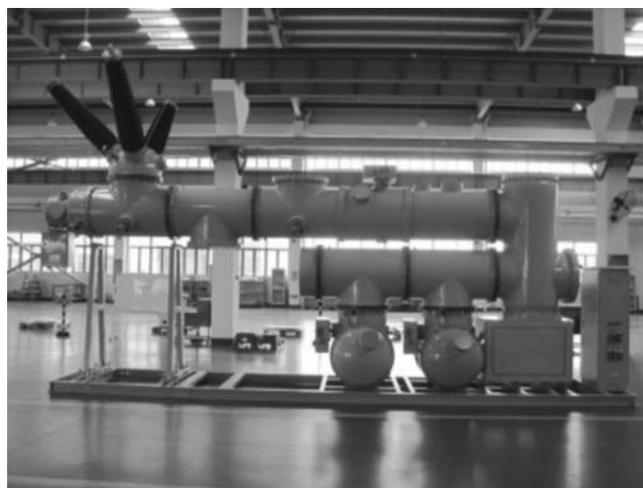
Рис. 3. Компактное КРУЭ 110 кВ для «интеллектуальных» электроэнергетических систем (ВЭИ)
