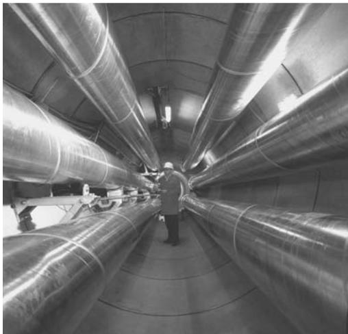
Рис. 4. Двухцепная линия с газовой изоляцией на напряжение 550 кВ («Сименс»)
