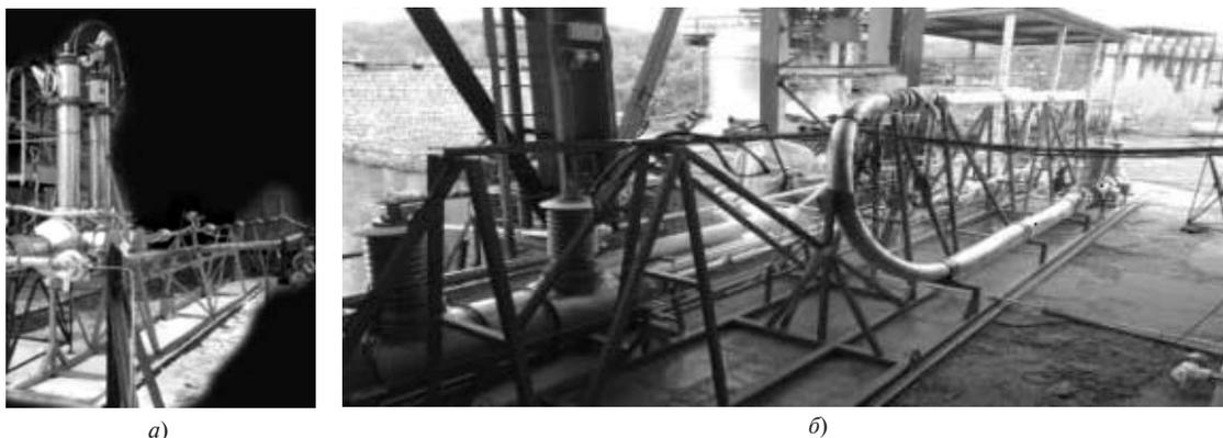
Рис. 14. Первые в мире модели гибридных транспортных энергетических линий: а – первая модель длиной 12 м; б – вторая модель длиной 33 м с гибким криостатом
