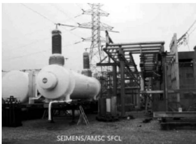
Рис. 18. Наиболее высоковольтный резистивный СОР на 138 кВ, снижение токов с 40–90 до 10–20 кА; справа – принципиальная схема (www.amsc.com)
