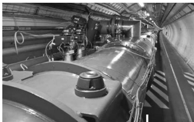
Рис. 8. Тоннель и криостаты сверхпроводящих магнитов самого крупного ускорителя (по материалам доклада Л. Боттура на конференции МТ-23, Бостон, США, 2013)
