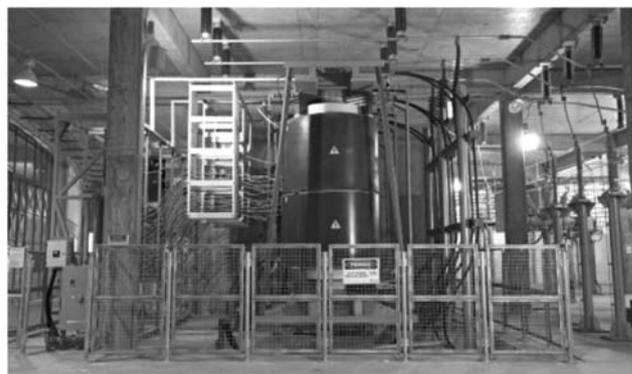
Рис. 3. Закрытая подстанция стадиона Fonte Nova и сухой трансформатор 69 кВ, 25 МВА
