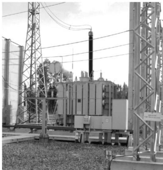
Рис. 2. Управляемый шунтирующий реактор напряжением 500 кВ мощностью на фазу 60 Мвар на подстанции «Нелым»
