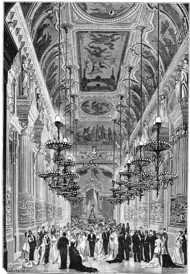
Рис. 12. Освещение «Большого фойе» с помощью ламп Эдисона, Максима и «солнечных ламп» Клерка
