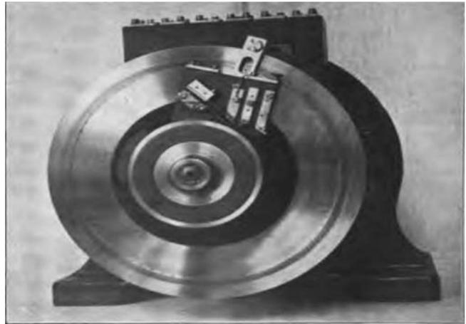
Контактный аппарат для исследования коммутации
