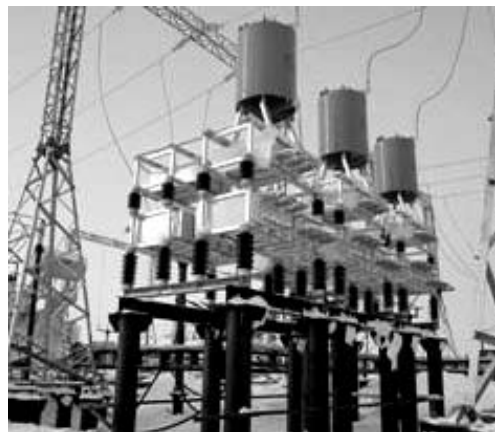
Рис. 5. Батареи статических конденсаторов мощностью 25 Мвар в составе ИРМ 35/25/25 кВ на ПС «Варандей»
