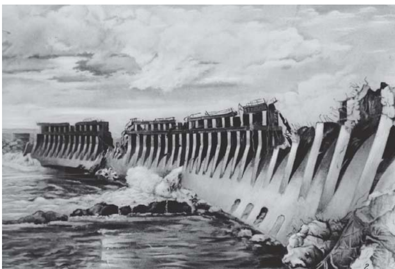
Плотина Днепрогэса после взрыва
