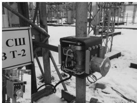
Рис. 3. Размещение устройства на валу привода разъединителя
